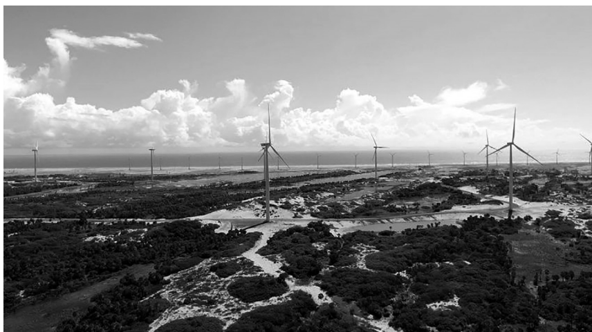
Figura 5 – Complexo Eólico Delta II no município de Ilha Grande-PI
